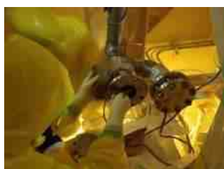
開放点検時系統内除染作業(1)
