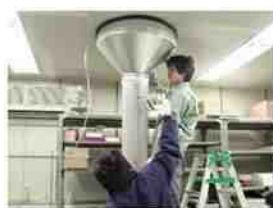
RI施設設備点検(風量測定)
