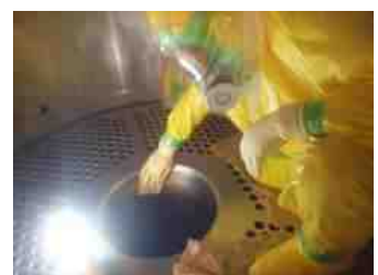
開放点検時系統内除染作業(3)
